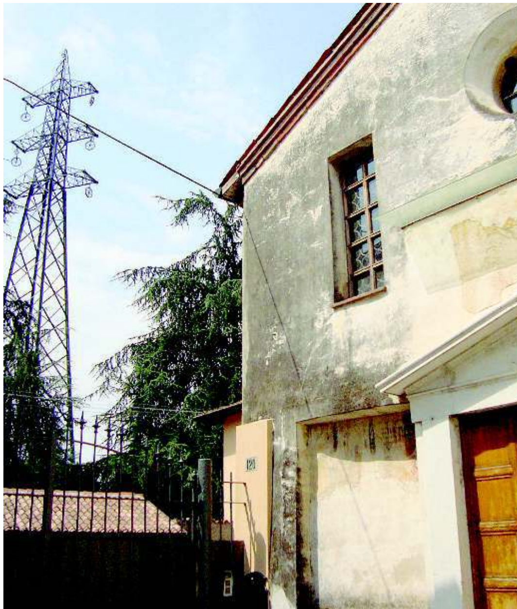
Uno dei due elettrodotti oggetto di polemiche e il Santuario di Lovernato
