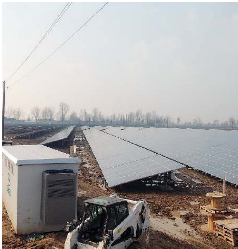
Il cantiere del parco fotovoltaico alla Barbaresca di Trenzano
